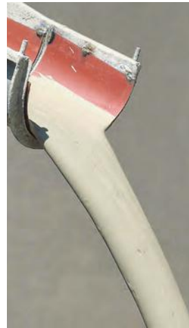
Končen izdelek je homogen lahko vgradljiv penobeton
